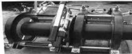
Gambar 3. 1. Proses Penyambungan Pipa
