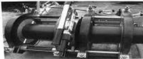
Gambar 3. 1. Proses Penyambungan Pipa
